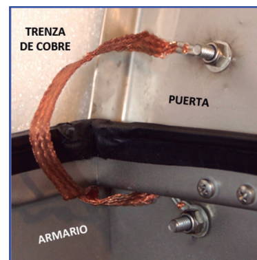
Figura 3. Trenza flexible de cobre de conexión entre la puerta y el armario. Forma una "U" al cerrar la puerta
